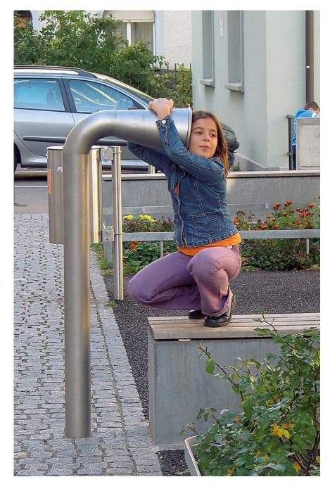
Schall verhält sich ähnlich wie Wasser. Man kann ihn, wie bei einem alten Schiffstelefon, durch Rohre leiten. Es können zwischen zwei und vier Sprechstelen installiert werden, die mit unterirdischen Rohren und einem speziellen Schallverteiler verbunden sind. So ist es möglich, sich ohne elektronische Verstärkung über ungewöhnlich große Entfernungen zu verständigen.
