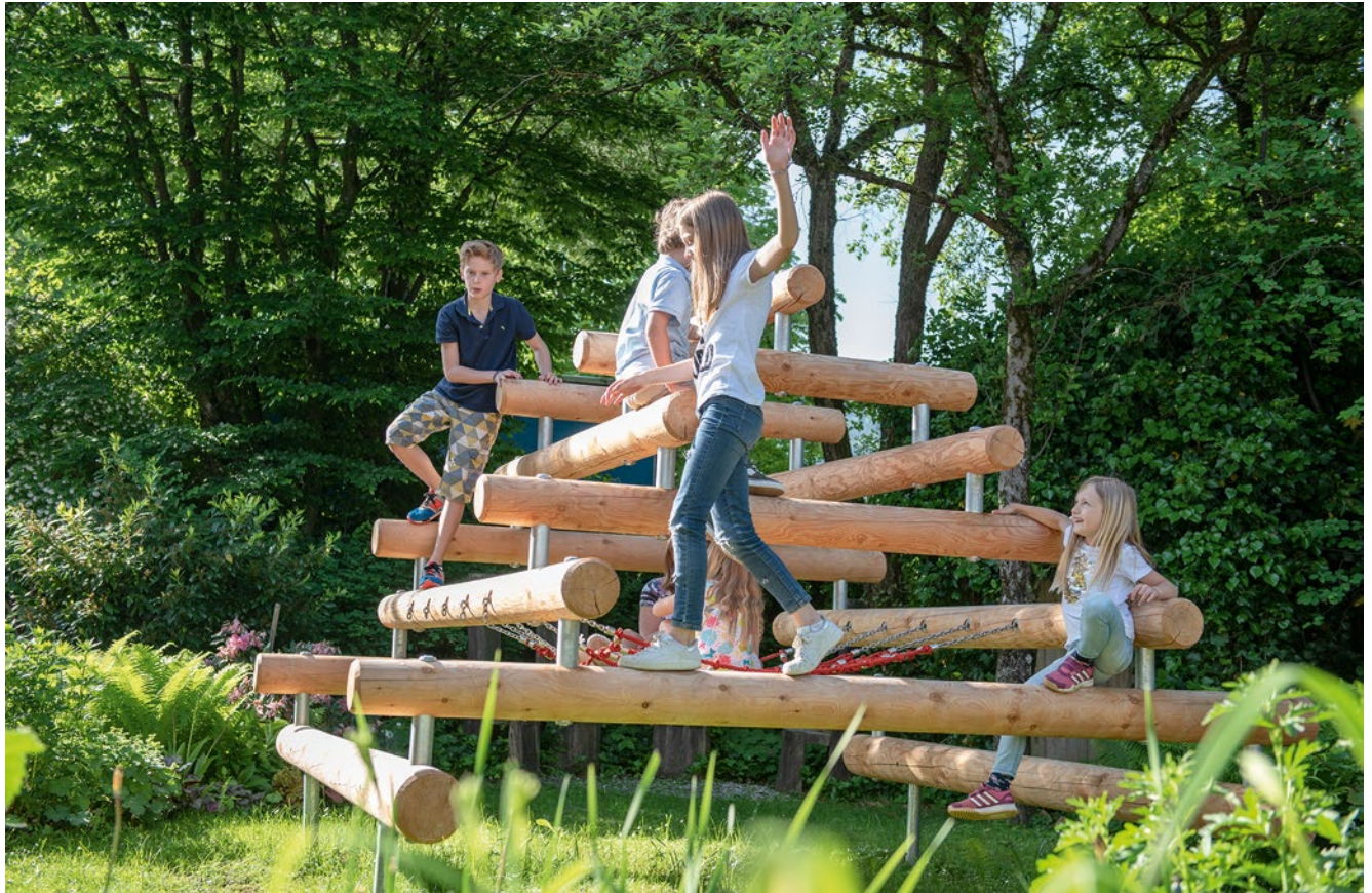
Bildbeispiel: Untergrund muss entsprechend einer Fallhöhe \leq 2,00 m gewählt werden.
