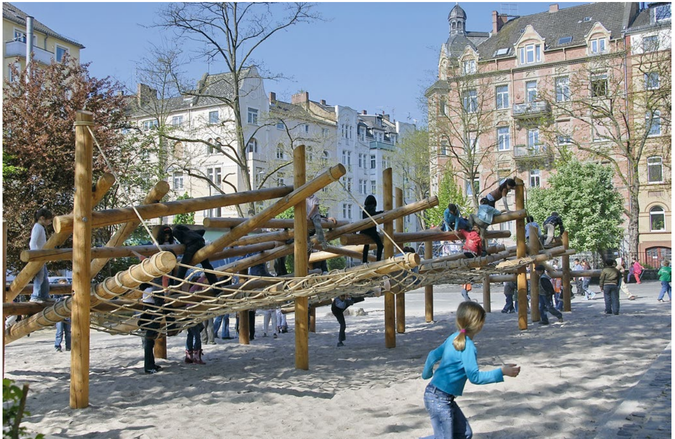
Das Foto zeigt die Ausführung in Lärche mit Stahlfüßen.
